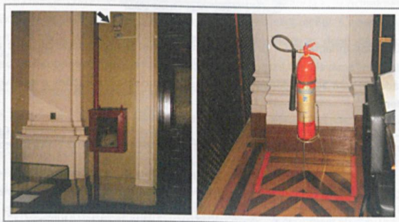
Foto 1 - Caixas de incêndio (hidrantes) existentes em todos os andares do prédio. As luzes de segurança (vide seta) existente nos corredores serão acesas em caso de desligamento geral do sistema de energia do prédio.
